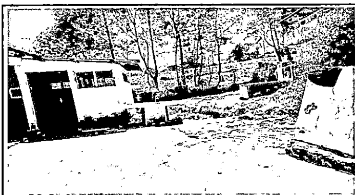
Foto 3: Ausencia de muro perimetral hacia la oriya del río.
